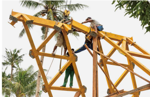
현지에서 나사와 볼트로 구조물을 조립한다. Assembling the structure with screws and bolts.
