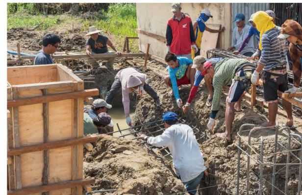
구조물을 설치할 콘크리트 기초를 세운다. Pour concrete and make a foundation for install the structure.
