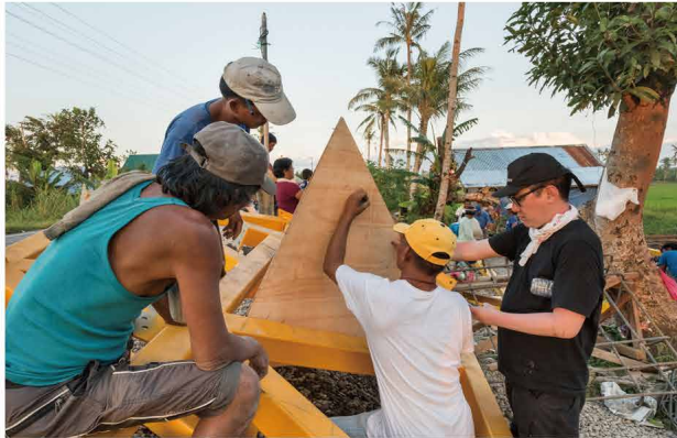
나무로 된 루버로 외부 입면을 만든다. Making the wood louver for exterior surface.
